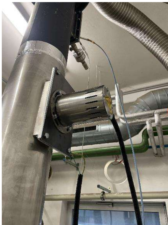
Obr. 3 Fotografie – elektrostatický odlučovač pro krby a krbová kamna
